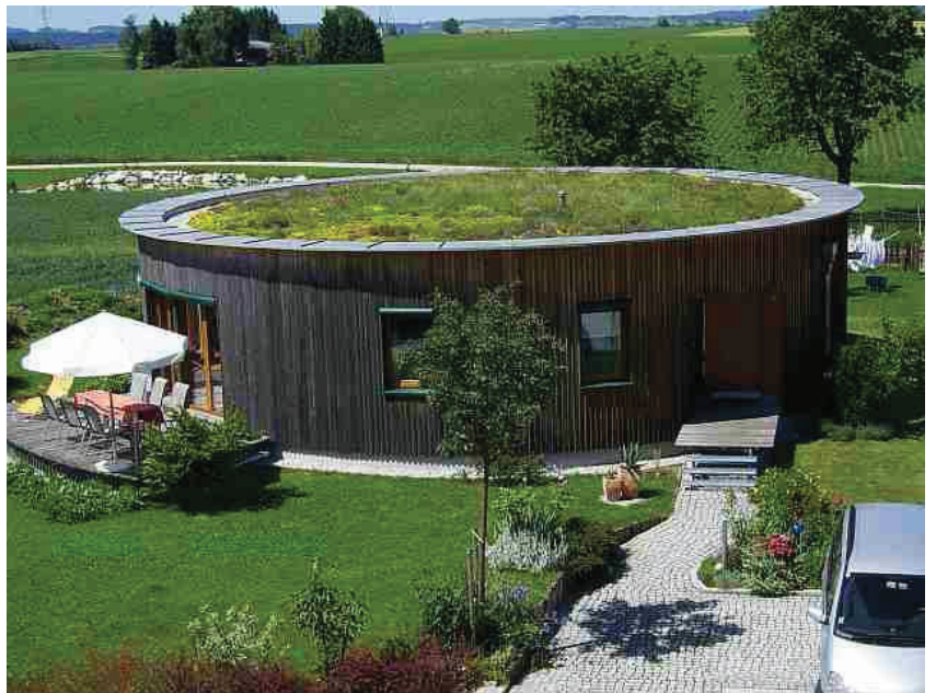
Construite en 2000, la maison de l'ingénieur Günther Lang, collaborateur de la branche autrichienne de l'institut PassivHaus, est le premier logement passif à avoir été certifié par l'institut allemand "PassivHaus". Photo : Günther Lang
