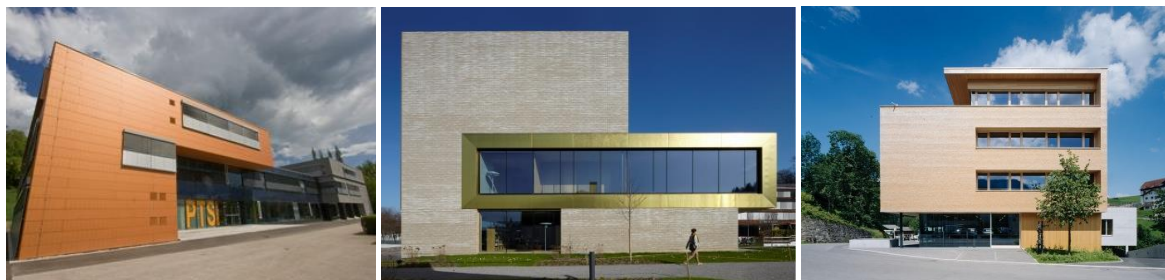
Drei Beispiele von 2.001 bis 10.000 Einwohner Gemeinden: Schulsanierung Schwanenstadt / PAUAT Architekten [Fotocredit LANG consulting], Musikschule in Wolfurt / Fink Thurnher Architekten [Fotocredit martin mischkulnig], Raiffeisenbank Mittelbregenzerald in Egg / Architekten Hermann Kaufmann ZT GmbH [Fotocredit Bruno Klomfar]
