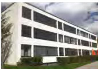
Bsp. Schulsanierung: Passivhaushülle, Klassenlüftung und gutes Sommerverhalten
