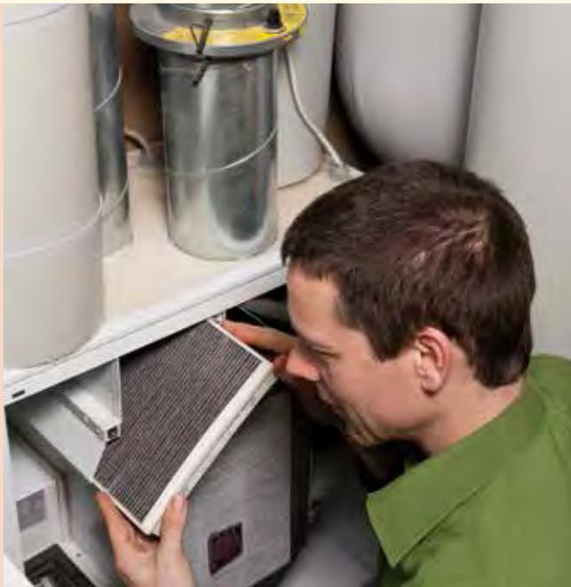
Lüftungsgerät mit Wärmerückgewinnung
