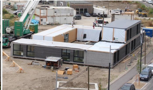
Bild 5+6) Bereits mit Anlieferung fertig eingerichtet. Montage der PopUp GreenFlexStudioBoxen am 2. Arbeitstag
