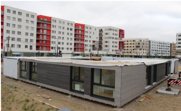
Bild 5+6) Bereits mit Anlieferung fertig eingerichtet. Montage der PopUp GreenFlexStudioBoxen am 2. Arbeitstag
