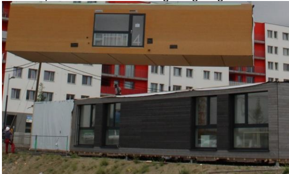
Bild 7+8) Montage der PopUp GreenFlexStudioBoxen am 2. Arbeitstag
