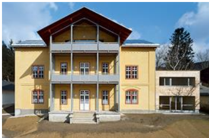
Gründerzeitvilla in Purkersdorf
