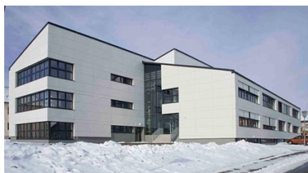
Schulkomplex in Rainbach/Mühlv.
